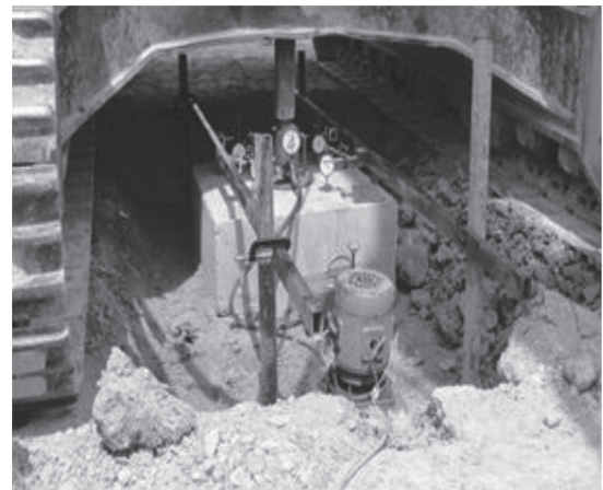
Hình 7: Thí nghiệm nén tĩnh hiện trường
