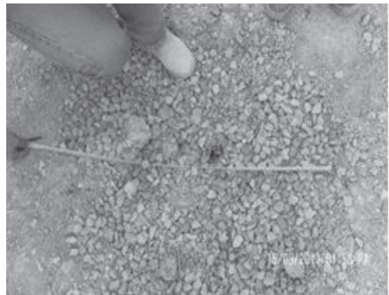
Hình 6: Thi công cọc đá hiện trường
